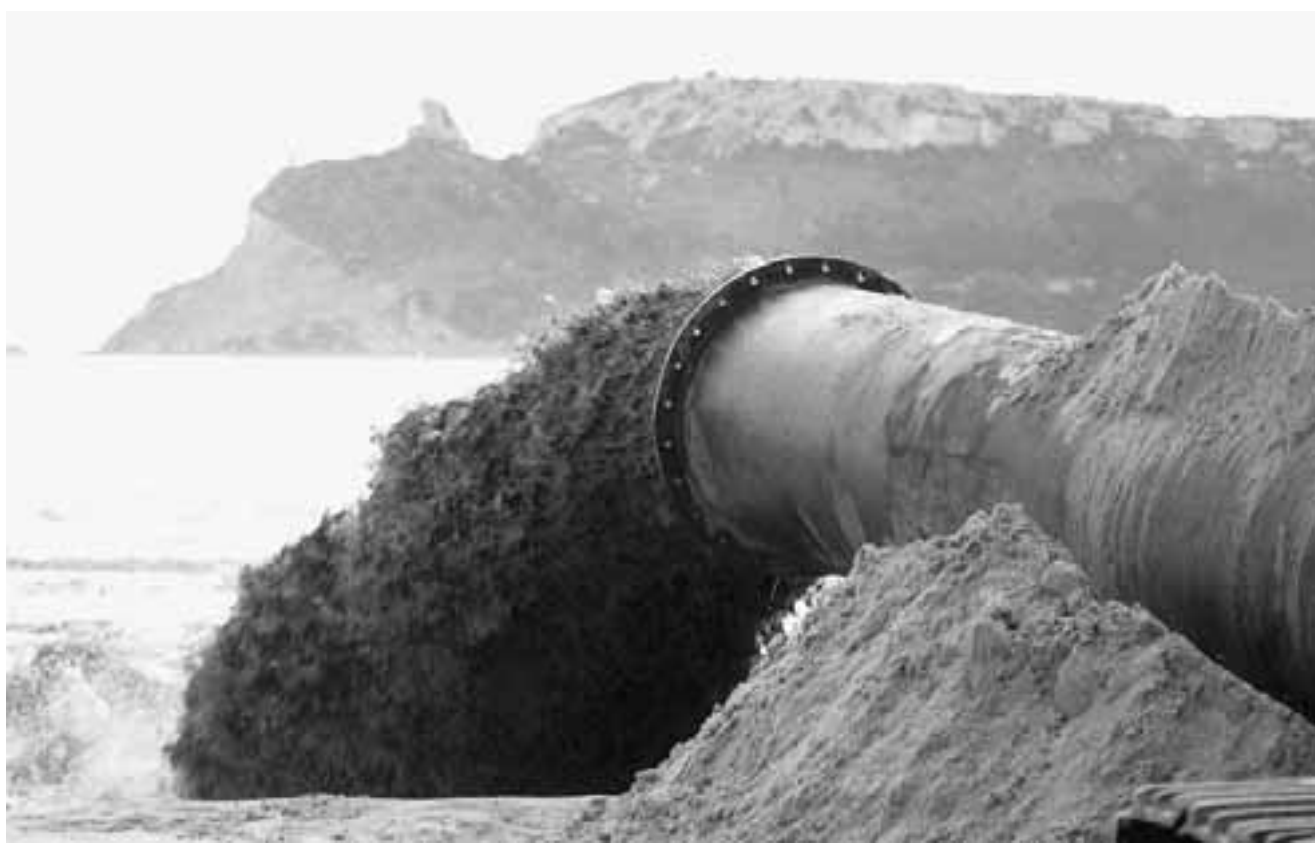
L'idrovora scarica sul Poetto la sabbia prelevata al largo: secondo la commissione collaudo, una parte del progetto non è stata rispettata.
